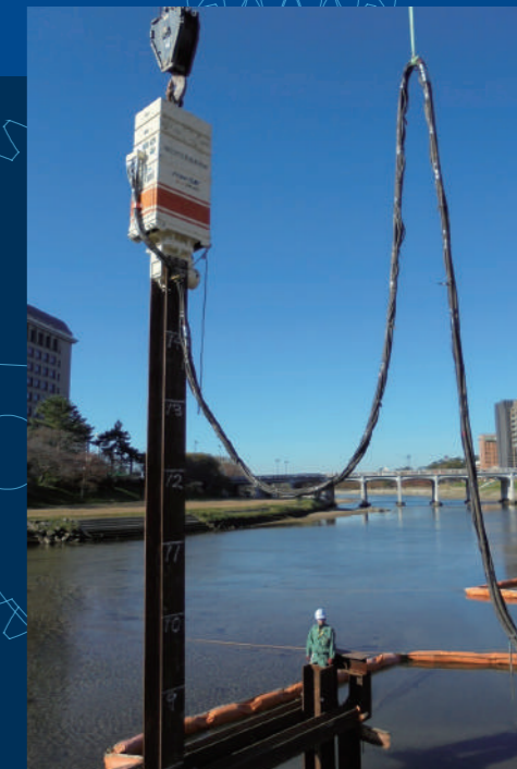
工事名: 乙川人道橋(仮称)橋梁下部工事 杭規格: 400H(L=17.5m) 発注: 愛知県岡崎市
