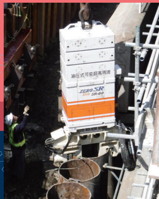
工事名: 横浜湘南道路引地川改良工事 (引抜き) 杭規格: 鋼管矢板Φ900(L=14.41m) 発注: 横浜市
