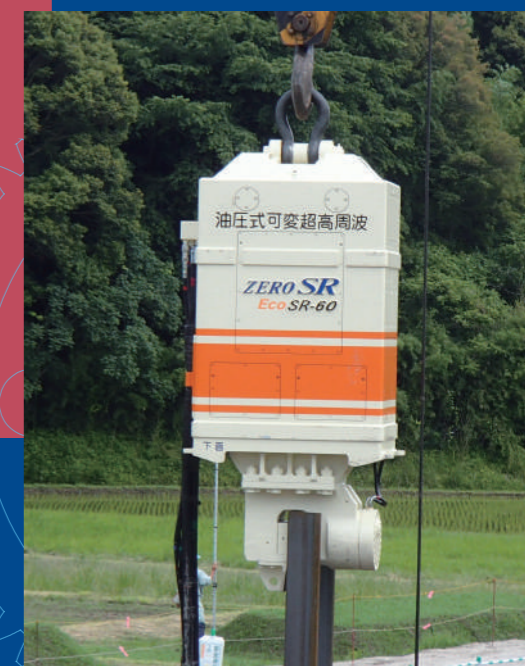
工事名: 鹿児島県伊佐市菱刈川 杭規格: 広幅鋼矢板Ⅲw型(L=10.5m) 発注: 鹿児島県
