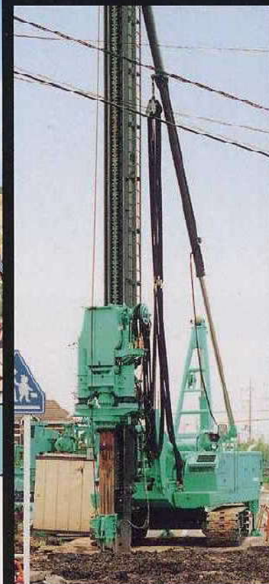
シート圧入作業
