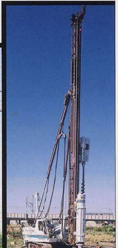
油圧ハンマ+油圧オーガ併用作業
